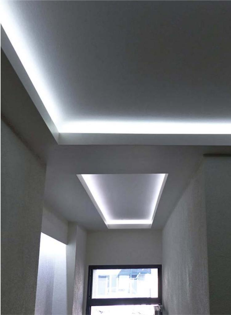
Lichtvouten an den Decken sorgen für eine indirekte Beleuchtung im Treppenhaus.
